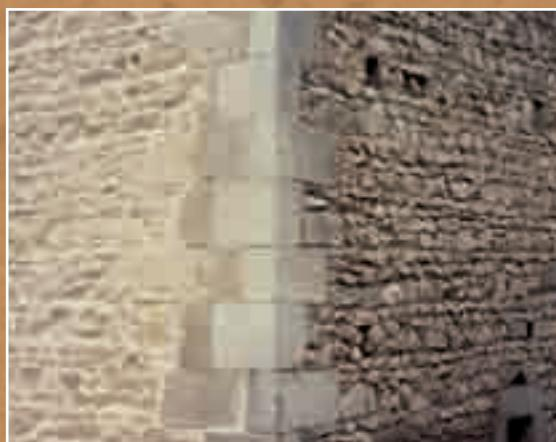
Dans la construction en pierre sèche, rare autour de Poitiers, la mise en œuvre ne nécessite pas de joints au mortier (Migné-Auxances).
