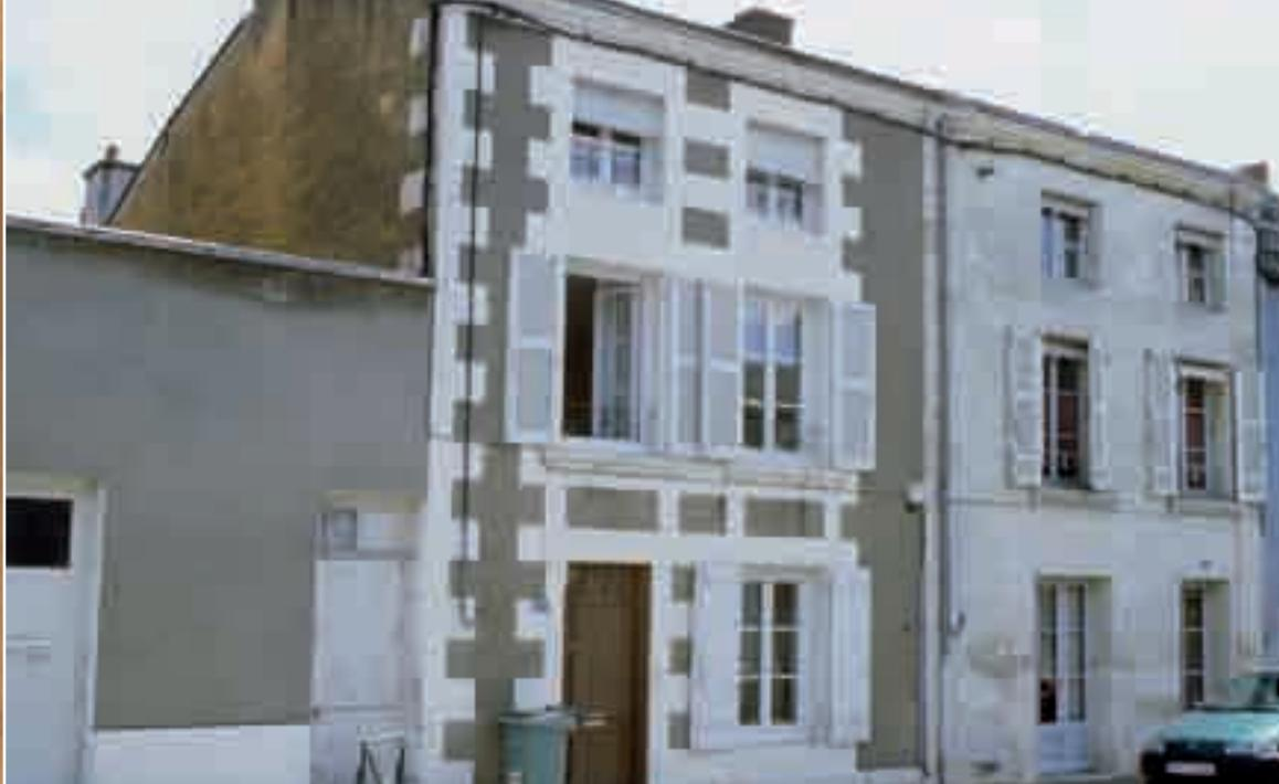
Jusqu'au XIX<sup>e</sup> siècle, les murs sont montés en moellons et recouverts d'enduit à la chaux. Ce revêtement a une fonction esthétique (cacher les moellons) et protectrice (protéger de la pluie, tout en laissant respirer le mur). La pierre de taille, laissée apparente, est réservée aux chaînages d'angle, aux encadrements de fenêtre, et éventuellement aux bandeaux et corniches.
