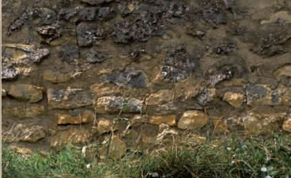
Les moellons sont généralement récupérés à proximité de la future construction, ramassés dans les champs, extraits du sol ou des coteaux. Broyé et cuit
