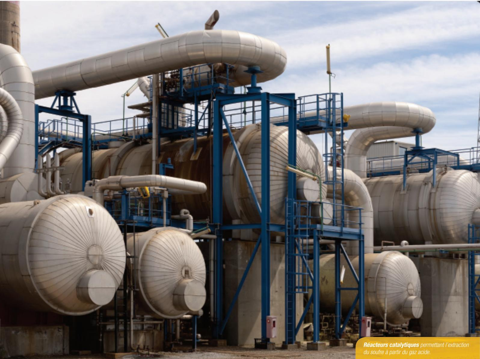
*Réacteurs catalytiques permettant l'extraction du soufre à partir du gaz acide.*
