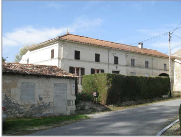
Logis de ferme de type saintongeais à la Balinière, avec toit à croupe, comble, bandeau et corniche.
