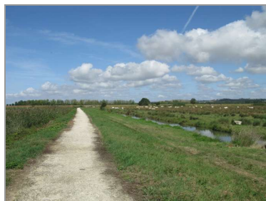
La digue entre les conches à gauche et les prairies à droite.
