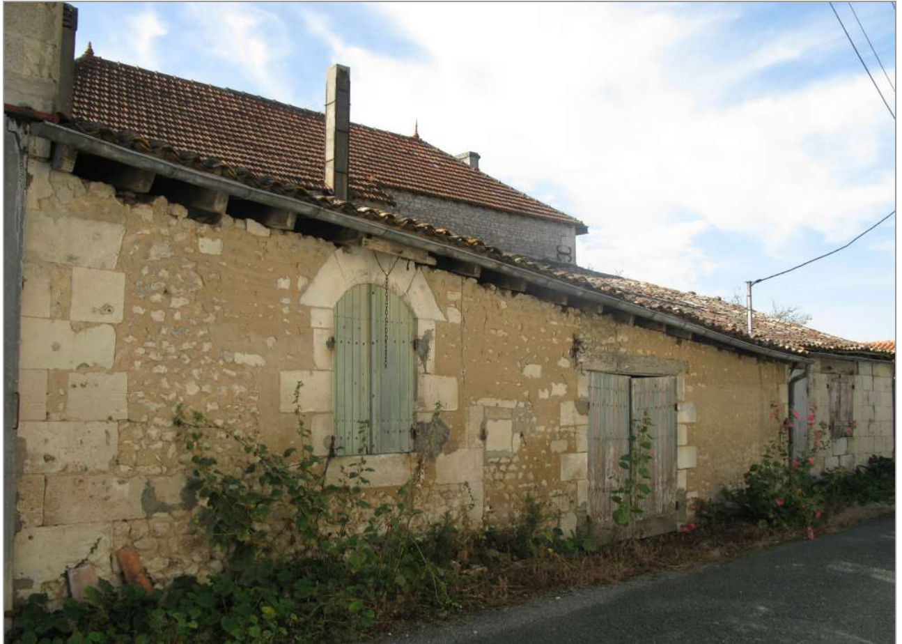
Ancien chai à la Noue.
