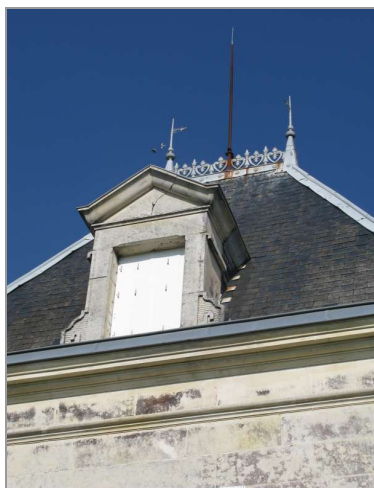
Toit en ardoise d'une maison de maître à la Grande Motte.
