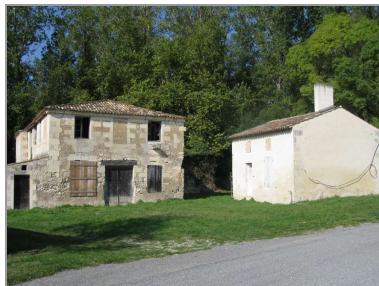
Ancien moulin à eau à Graveteau.
