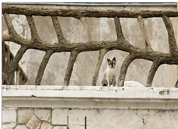
Garde-corps en faux-bois de ciment (milieu du 20 e siècle), dans le bourg (R. Jean).
