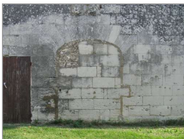
Ancienne porte de chai à la Petite Motte.
