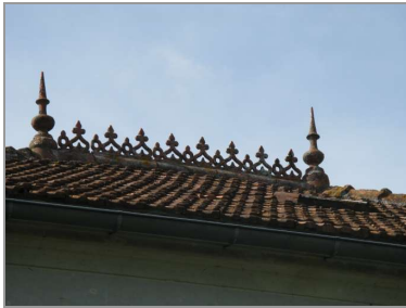
Épi et crête de faîtage sur une maison du bourg.
