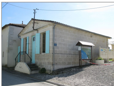
L'ancienne école, construite en 1866.
