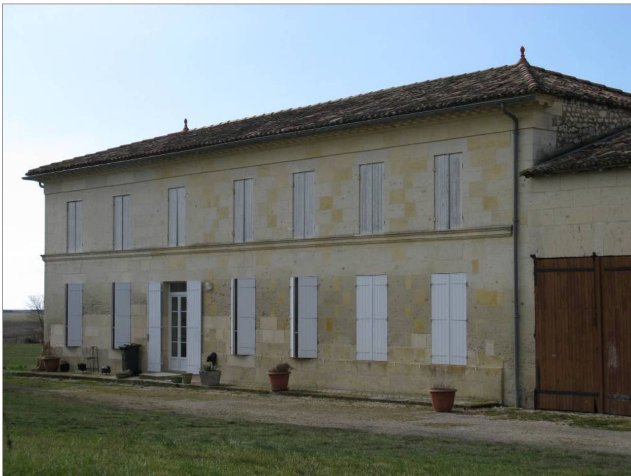
Logis de ferme des années 1860, au Pontet.
