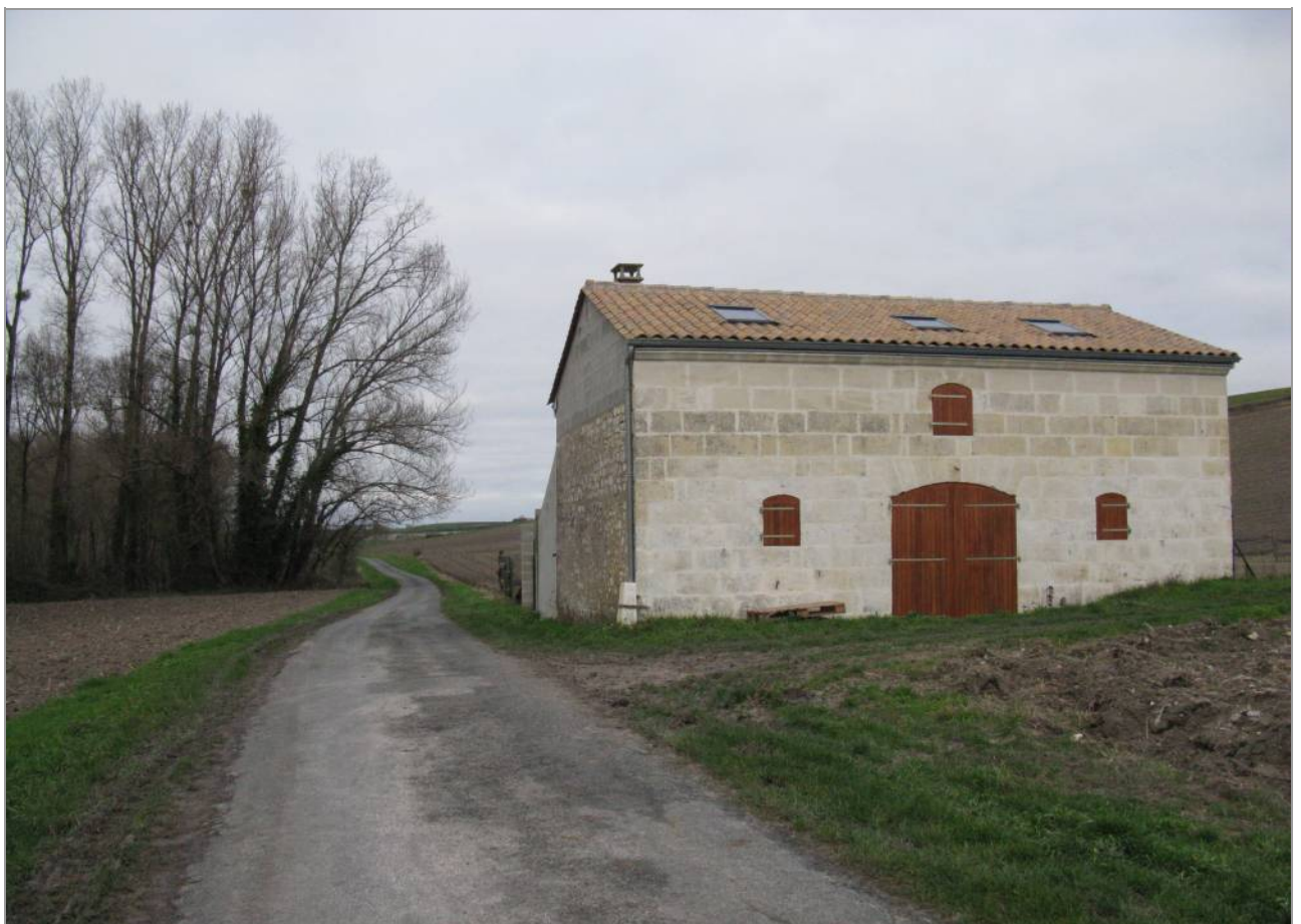
Ancienne grange en bordure des marais.
