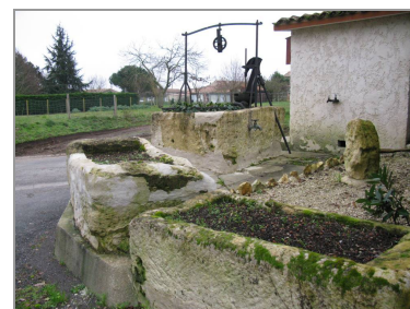
Puits commun à Féole.
