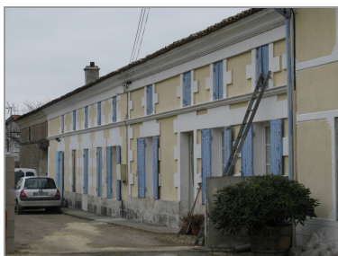
Façade avec bandeau et corniche, à Mageloup.
