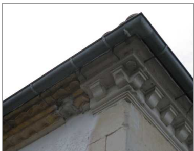
Génoise double, à gauche, et corniche à modillons, à droite, sur une maison du bourg de Chenac.
