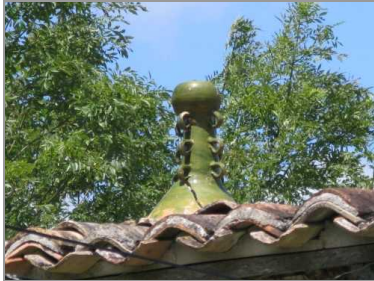
Épi de faîtage en terre cuite vernissée aux Rimondières.
