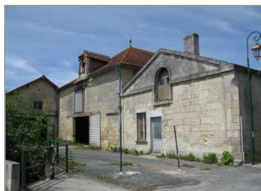
Ancienne fabrique de raisins secs puis entrepôt, dans le bourg de Saint-Seurin-d'Uzet.
