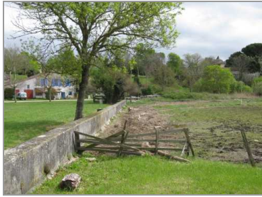
Digue construite à partir de 1895 sur la rive gauche du port de Saint-Seurin-d'Uzet.
