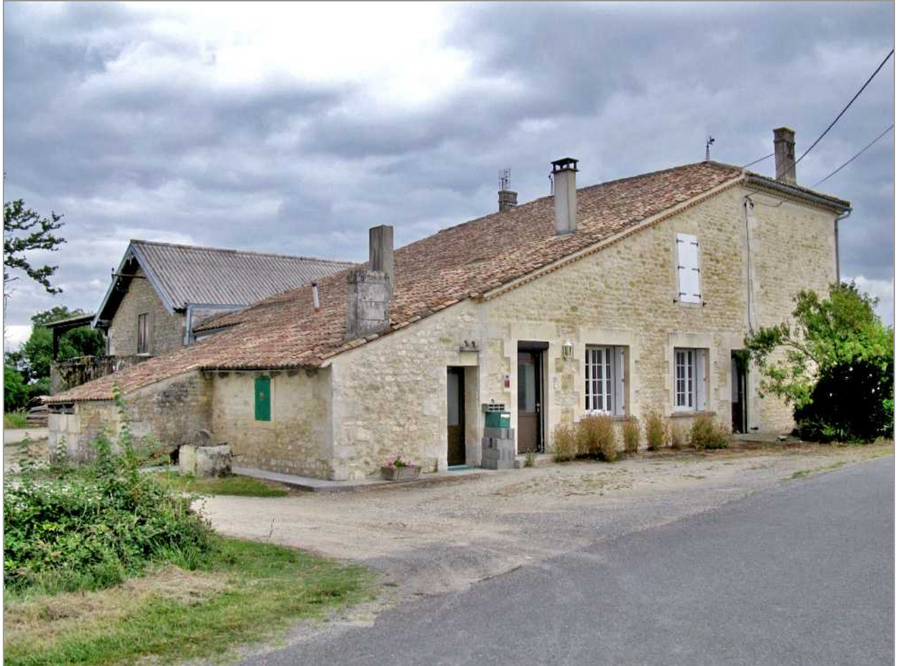
Dépendances en appentis à l'arrière du logis, à la Garenne.
