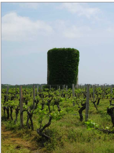
Ruines du dernier moulin du Petit-Chenac.
