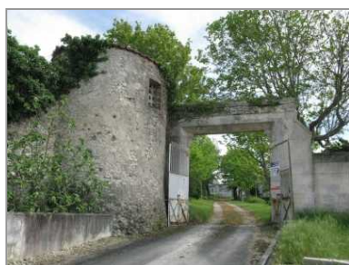
L'entrée du château.
