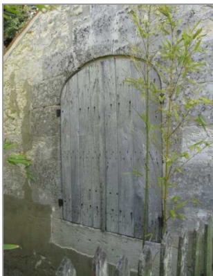
Fenêtre de décharge d'un chai à la Toinette.
