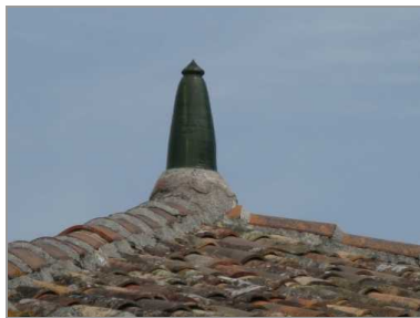
Épi de faitage en terre cuite vernissée, en forme de poire, à la Tuilerie.
