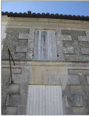
Bandeau et corniche sur une façade à l'Echallier.
