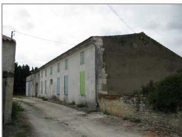
Maison avec rez-de-chaussée et comble, Chez-Bouron.
