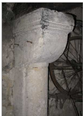
Détail d'une cheminée du 16 e ou 17 e siècle, Chez-Couraud.
