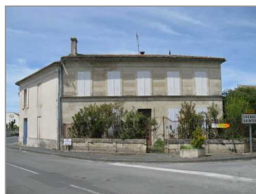
Maison à étage dans le bourg de Saint-Seurin-d'Uzet.
