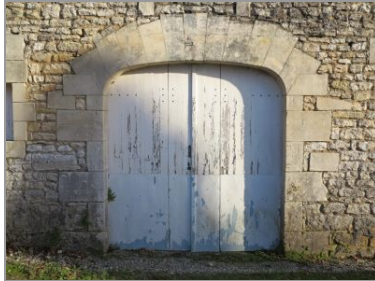
Porte de chai aux Maisons Neuves.
