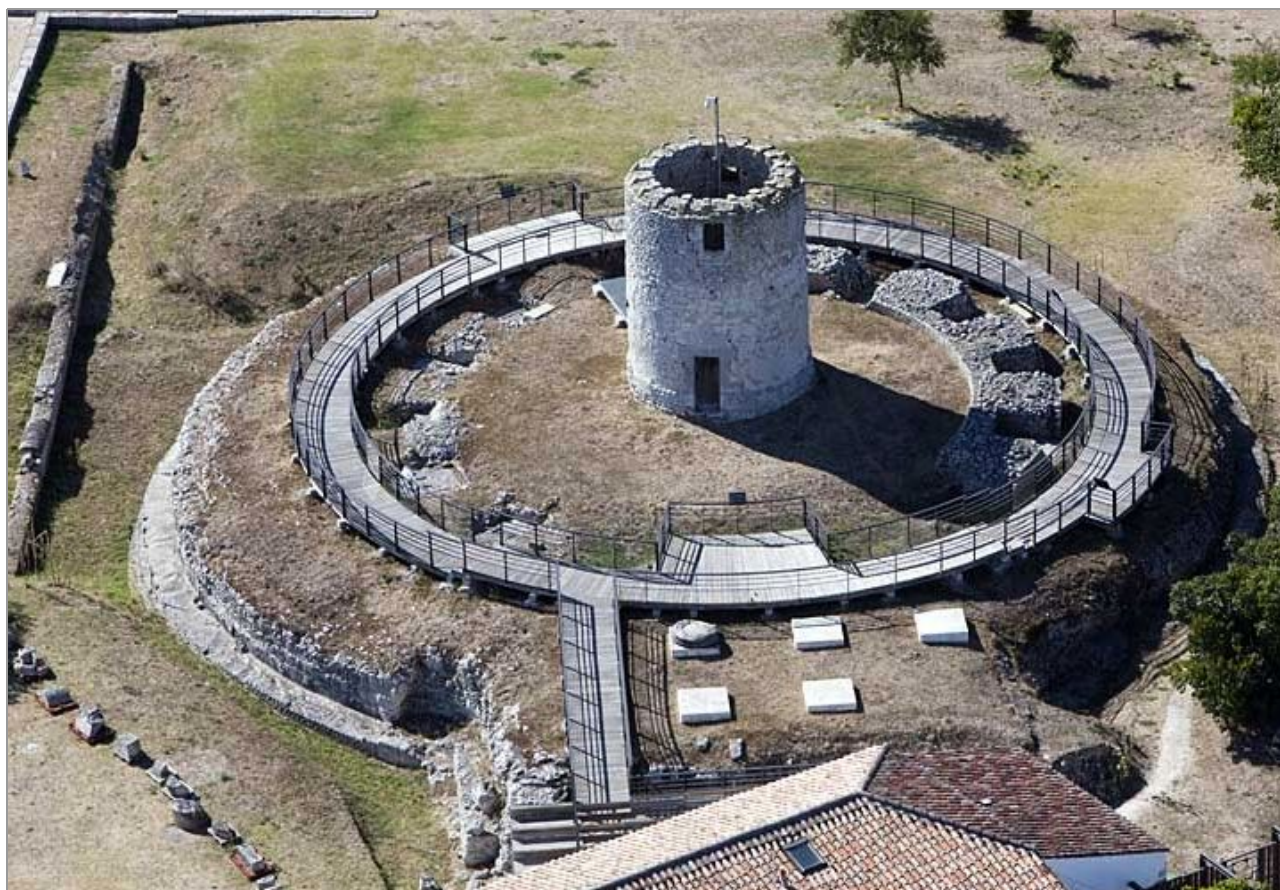
Le moulin du Fâ. Vue aérienne.
