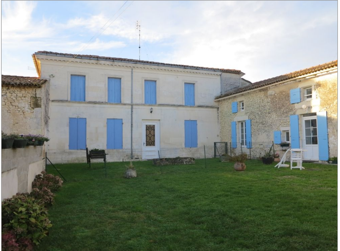
Maison construite dans les années 1860, à Fontboire.
