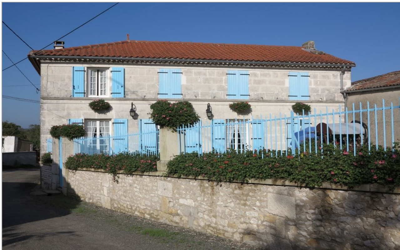
Maison de type saintongeais, avec croupe de toit à gauche, comble habitable et bandeau en façade, Chez-Garnier.
