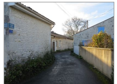
Ruelle et anciennes fermes aux Maisons Neuves.
