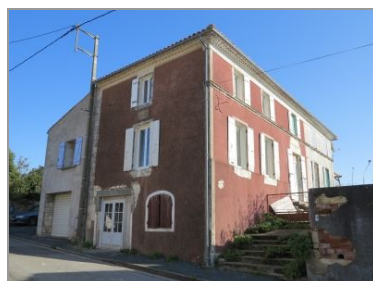
Maison dite rurale avec chai en soubassement, dans le bourg.
