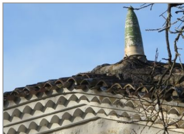
Génoise double et épi de faîtage, aux Maisons Neuves.
