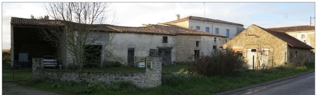
Dépendances d'une ancienne ferme à Fontboire.
