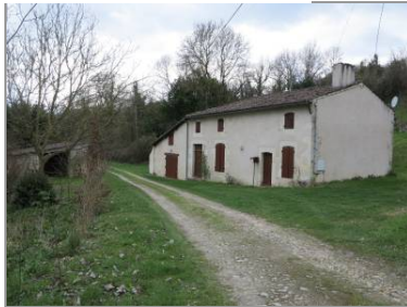
Maison du 18 e siècle en rez-de-chaussée avec grenier, à Lorivaux.
