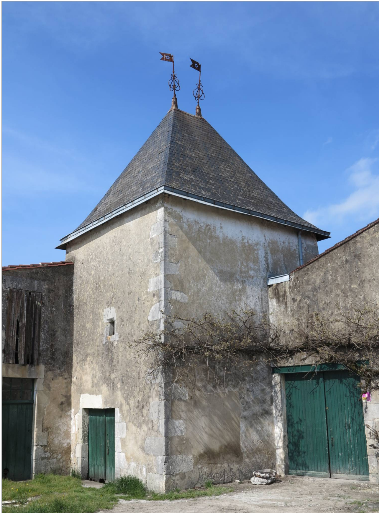
Un des pavillons d'angle du château de Conteneuil.
