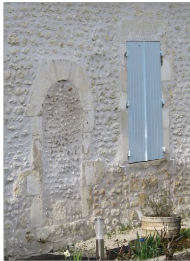
Porte du 18 e siècle, murée, au Maine-Moutard.
