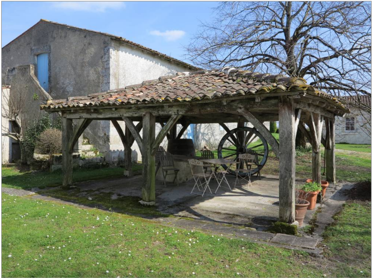
Puits charpenté au Grand Theuillac.
