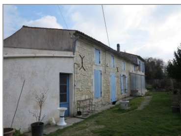
Façade avec trois travées d'ouvertures à Chassagne.
