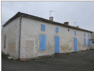
Maison en rez-de-chaussée avec grenier, à Liboulas.
