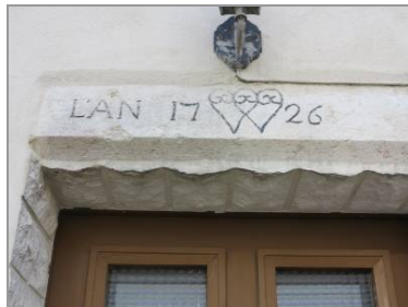
Pierre datée de 1726, remployée au-dessus d'une porte dans le bourg.
