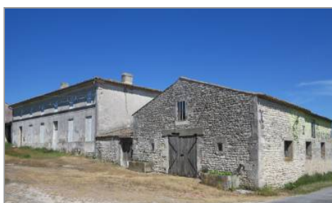
Ancienne ferme au Caillaud, construite en 1870.
