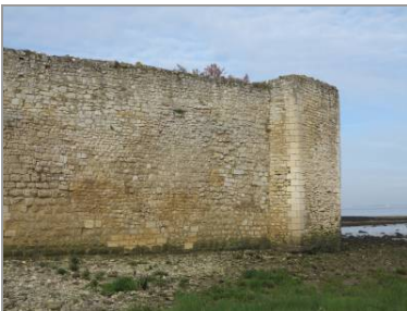
Le mur nord et la demi-tour nord-ouest.
