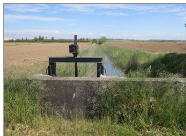
Vanne et fossé dans les marais desséchés.
