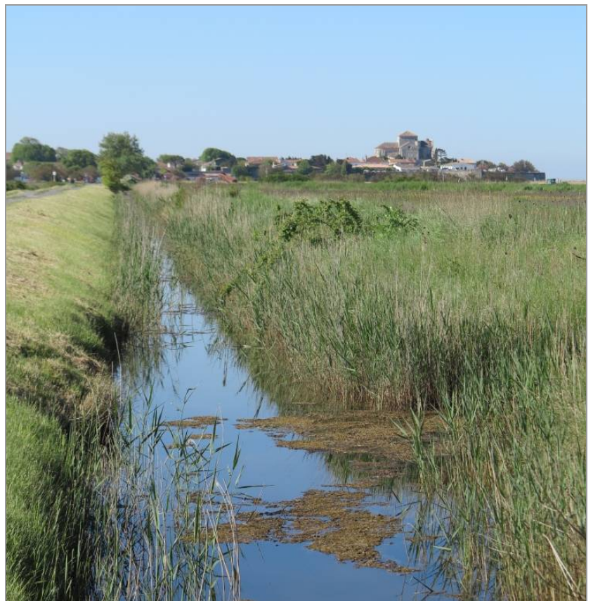
Fossé d'évacuation dans les marais desséchés.
