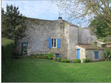
Maison en partie aménagée dans le rempart nord.
