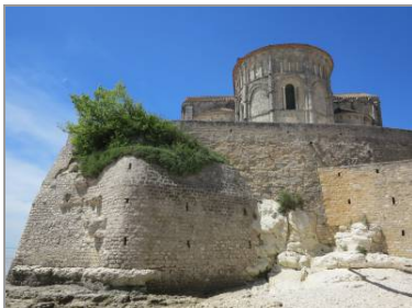
Le soutènement de l'église, réparé après la tempête de 1999.
