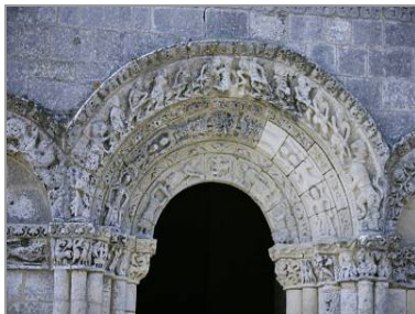
Détail du portail nord (C. Rome).
