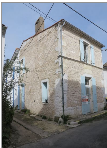
Maison avec une travée d'ouverture (2 e moitié du 19 e siècle), rue des Écoles.
