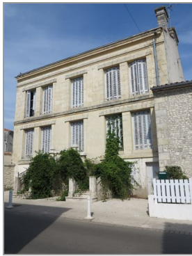
Maison construite en 1884, 42 rue Paul-Massy.
