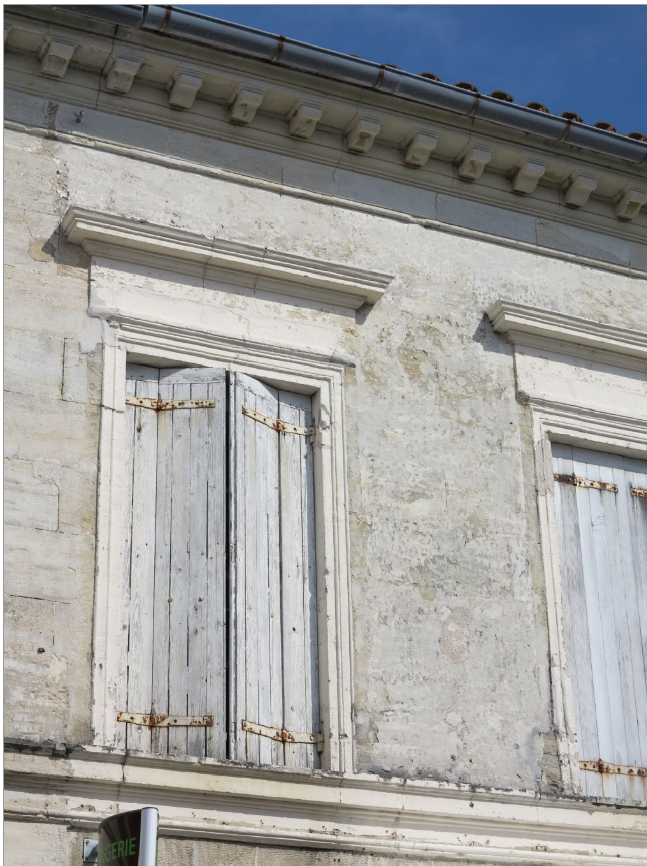
Détail d'une façade de la seconde moitié du 19 e siècle, rue Paul-Massy.
