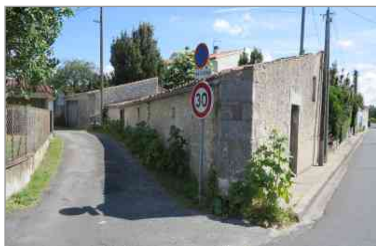
Maisons présentant des éléments antérieurs à la Révolution, 32-34 rue de Saujon, à Didonne.
