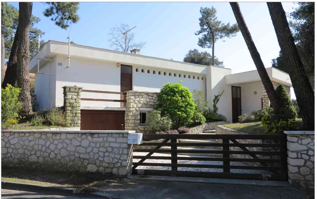
Villa moderniste (années 1950), avenue des Frégates.
