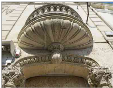
Détail de la maison "Fernande" (1907), rue Henri-Collignon.
