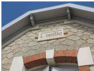
Détail de "L'Oustao" (1925), villa de type cottage, rue Louis-Barthou.
