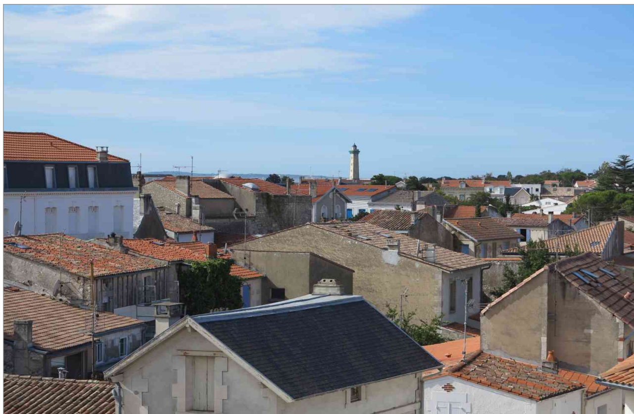
Le bourg, aux constructions particulièrement denses.
