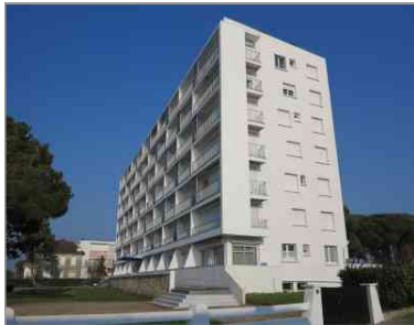
La résidence "Océanic", à Vallières, construite en 1958.
