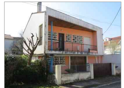
Villa moderniste (1960), avenue Mestreau.
