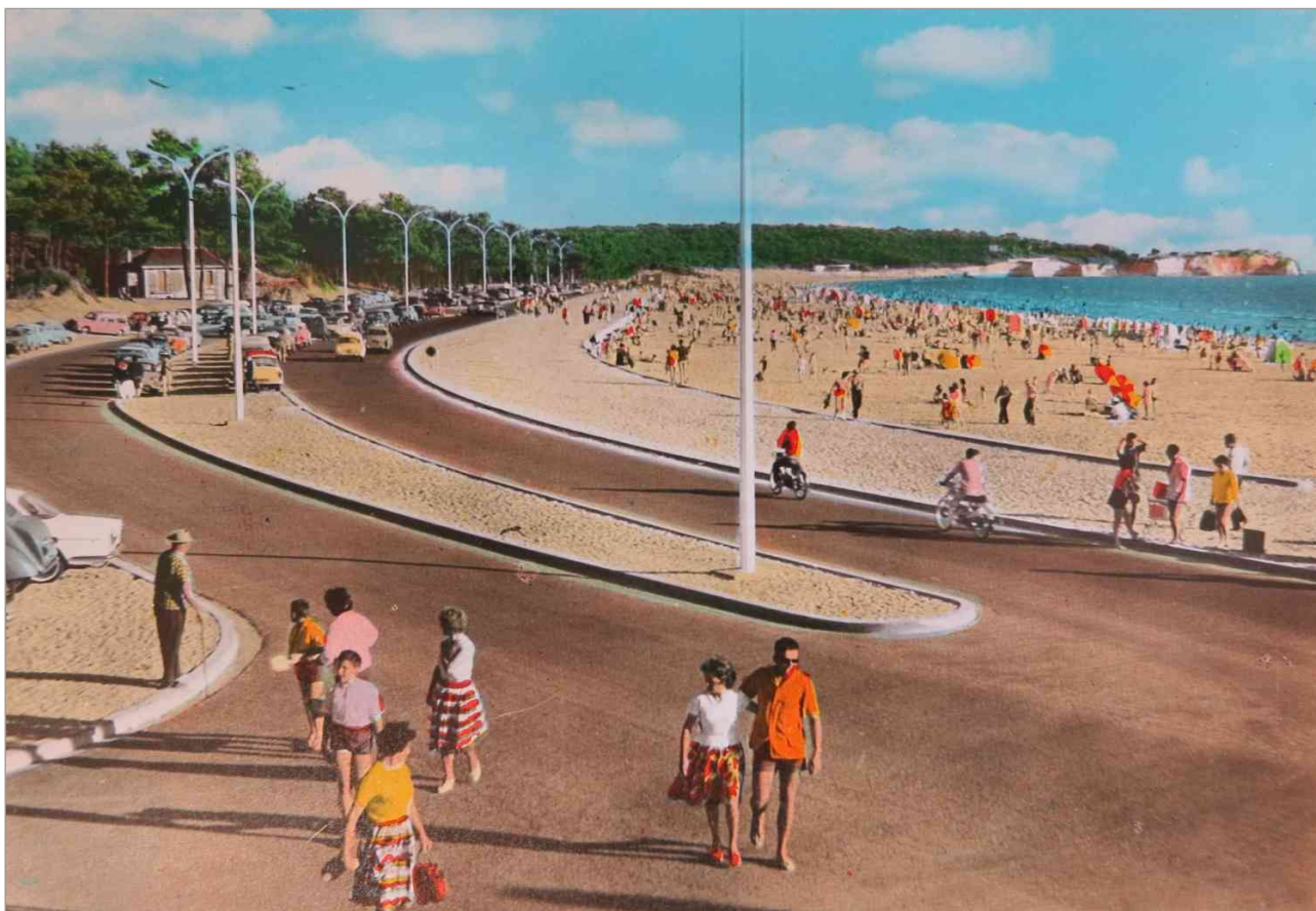
Le nouvel aménagement du front de mer, vers 1960-1970 (Archives départementales de la Charente-Maritime, , 14Fi).
