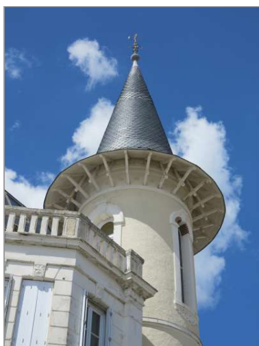
La tourelle de la villa "Saint-Cloud" (vers 1900), 54 boulevard Garnier.
