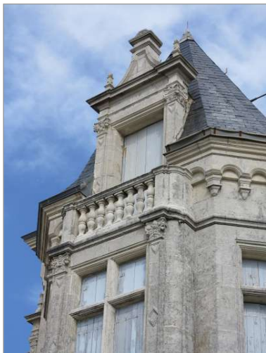
Détail de la villa "Castel Horizon" (1907), à Pontailiac.
