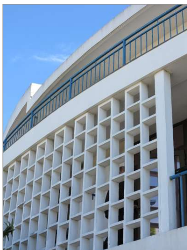
Détail de la "maison Council" : claustra.
