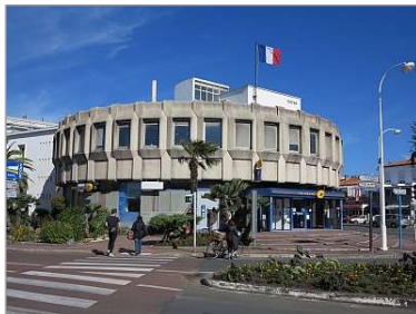
La poste, reconstruite en 1955 et remaniée au début des années 1980.
