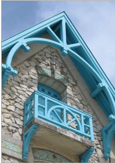
Détail de la villa "Hélianthe" (vers 1900), 77 boulevard de la Côte d'Argent : ferme de charpente apparente et balcon en bois.
