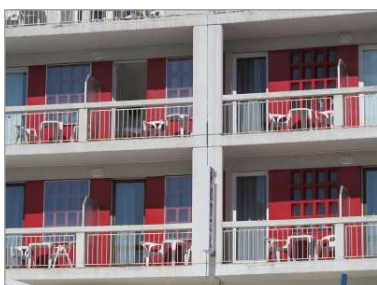
Détail du Front de Mer : balcons, traitement en rouge et blanc.
