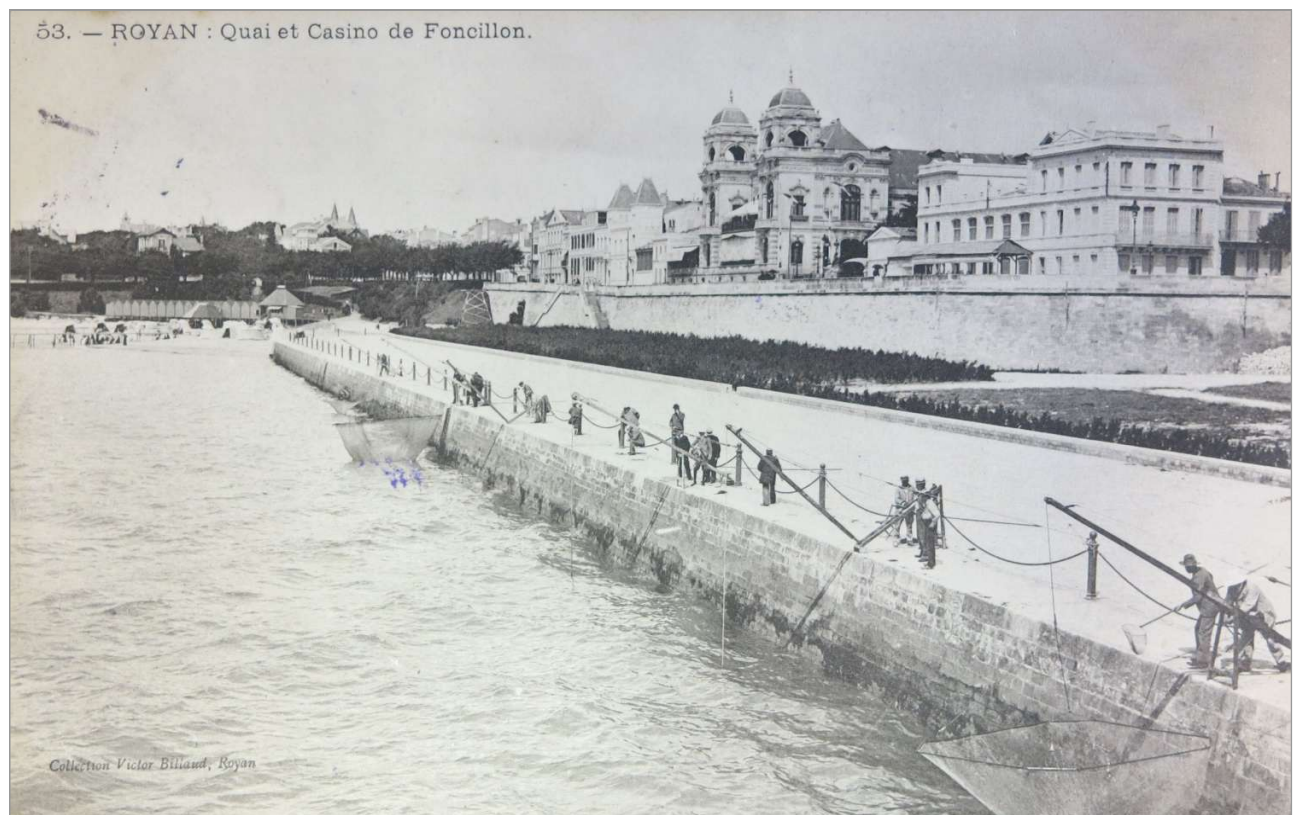
La façade de Foncillon vers 1900 (Archives départementales de la Charente-Maritime, 78Fi).
