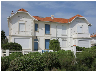
Deux cottages accolés : "Brise Lame" et "Coupe Vent" (début du 20e siècle), 49 boulevard de la Falaise.
