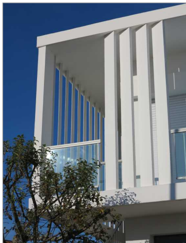
Brise-soleil de la villa "Ker Mag" (vers 1955), 23 boulevard de la Côte de Beauté.
