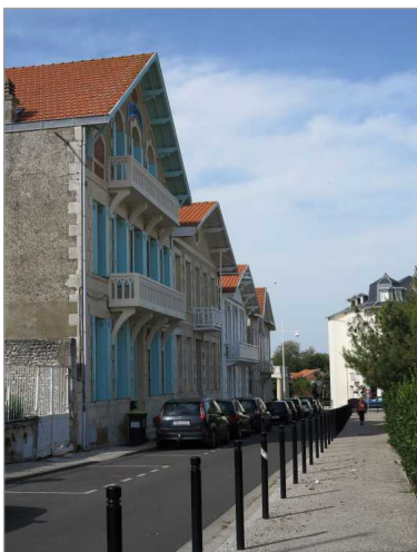
Suite de chalets le long de la falaise de Pontailiac.
