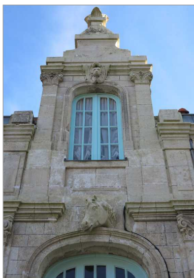
Détail des anciennes écuries d'une villa de Pontailiac, rue Benjamin-Delessert.
