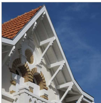
Détail d'une villa de la fin du 19 e siècle, rue de la Plage.
