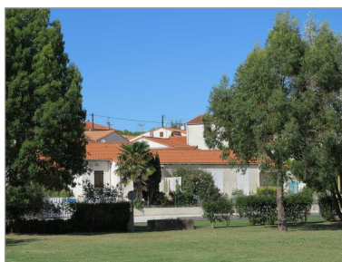
Lotissements au bord des anciens marais de Nauzan.
