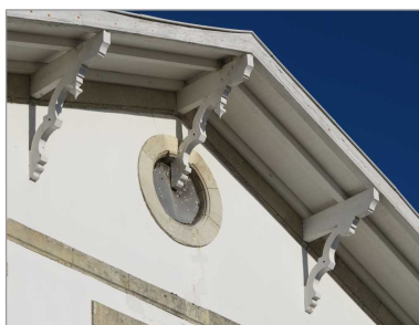
Détail d'un chalet à Pontailiac : aisseillers soutenant le débordement de toit.
