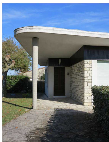
Détail d'une villa (vers 1965), 2 rue du Périgord : casquette en béton abritant la porte.
