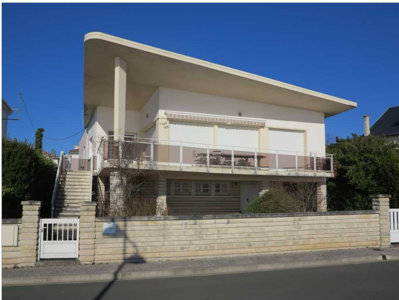
"Diama Reck" (vers 1955), 39 boulevard de la Falaise, avec sa casquette de béton.
