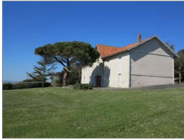
L'ancien bureau de la douane, qui a donné son nom à la station du Bureau.
