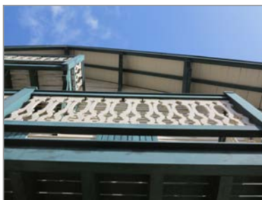
Détail de "Nelly" et de sa façade en bois, rue de l'Océan.
