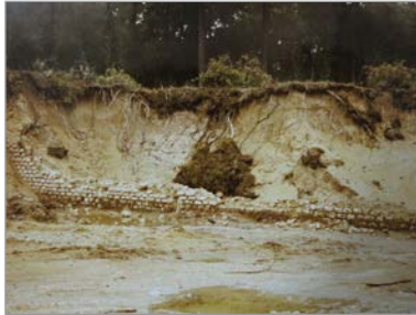
Vestiges d'un mur romain mis au jour sous le sable et la forêt en 1981.
