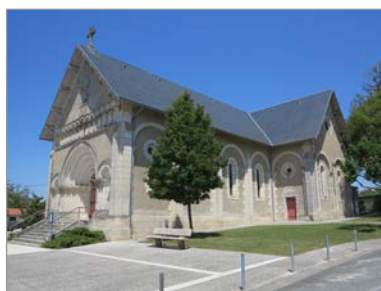
La nouvelle église du Bureau (1911).
