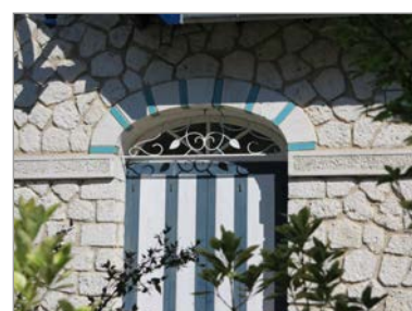
Parement de moellons sur "Marine", 6 rue Henry-Neaud.
