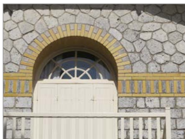
Moellons de formes différentes sur "Annette" (1913), 18 avenue de Pontaillac.
