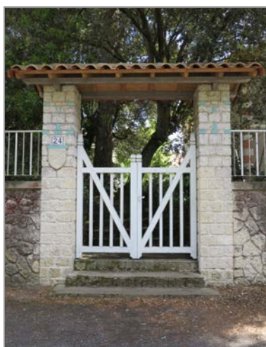
Portail de "Marjolaine" (1913), 24 avenue du Platin, avec écusson et briques vernissées.
