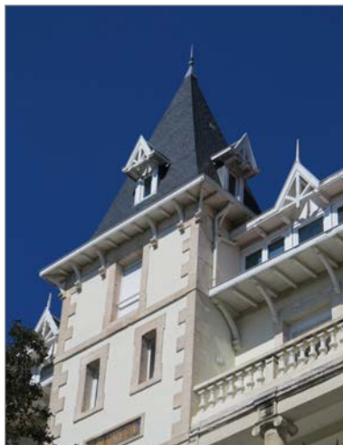
"Bon Accueil", construite en 1900 au Bois du Roi pour M. Paquet.
