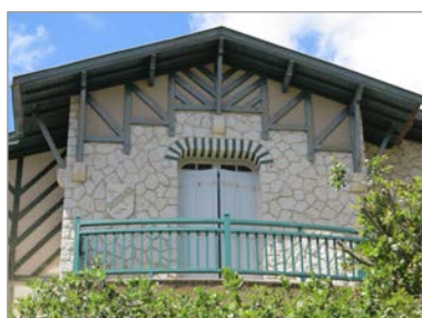
Pans de bois sur "Les Moineaux", 11 avenue des Pierrières.
