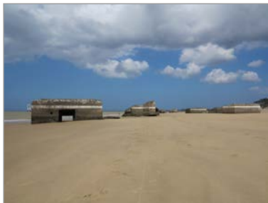
Les blockhaus de la plage de la Grande Côte.
