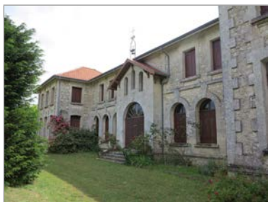
L'ancienne maison de repos "Béthanie".
