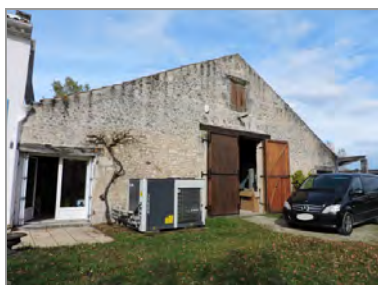
Grange-étable à façade sur le mur pignon, aux Charmettes.
