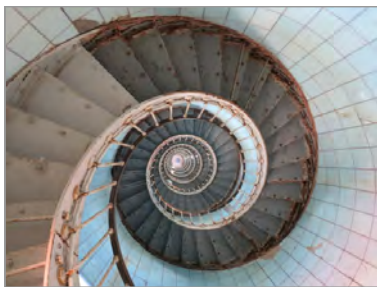
La cage d'escalier du phare de la Coubre, carrelée d'opaline.
