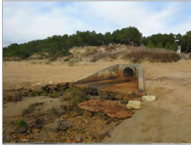
L'exutoire du marais de Bréjat, qui a remplacé l'ancienne vanne ou clapet.
