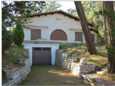
Villa de type chalet (1954), 25 avenue de la Coubre.
