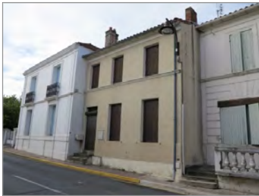
Maisons attenantes (2 e moitié du 19 e siècle) dans le bourg, rue du Clapet.
