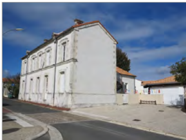
La mairie-école, construite en 1877.
