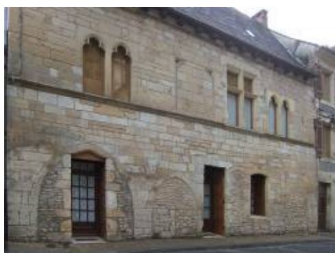
Maison du n°70 rue de Juillet (cliché X. Pagazani)
