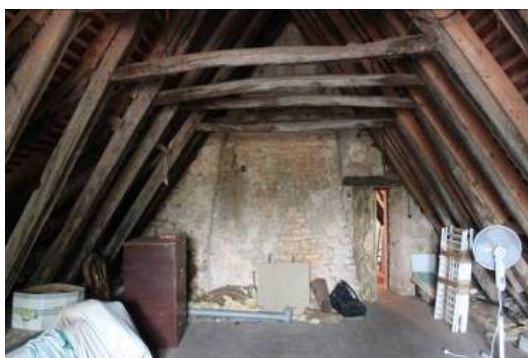
Charpente de la rue des Jardins (cliché X. Pagazani)
