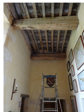
2e étage – couloir Dauvet
