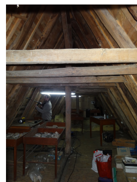
Charpente – zone 1 – partie haute
