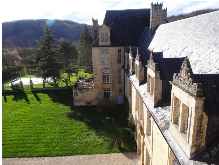
Le château de Sauveboeuf – vue depuis la charpente du pavillon arrière droit
