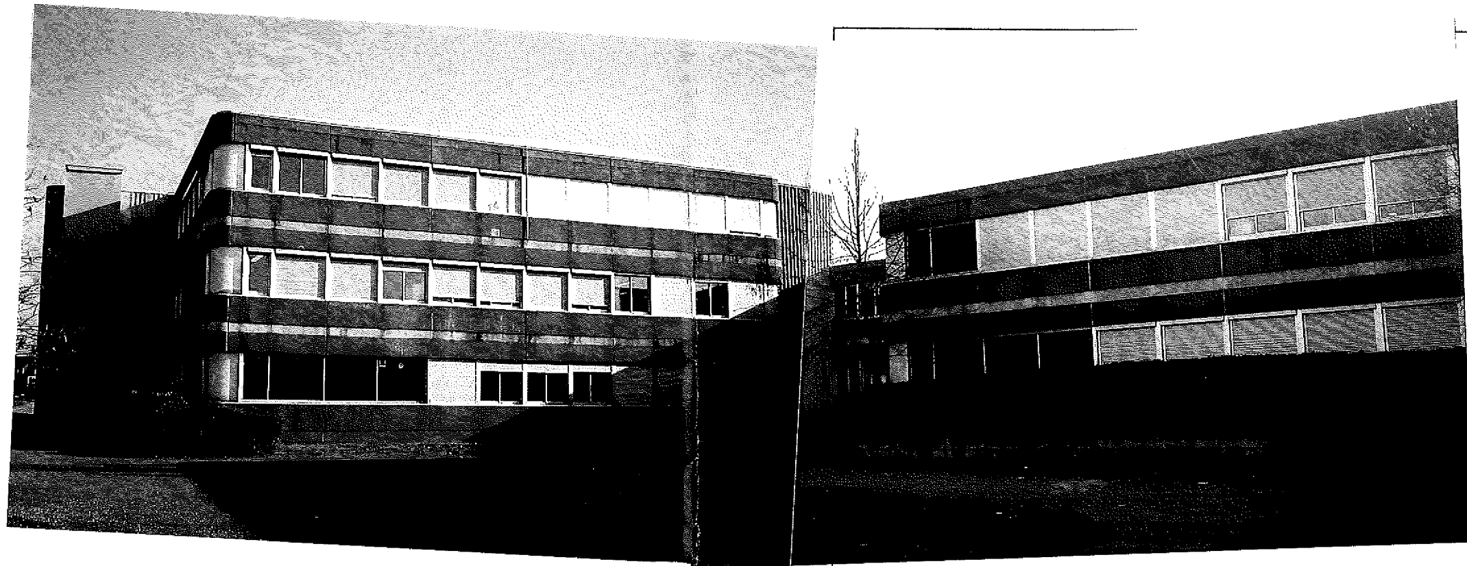
façade Nord-Ouest depuis petite cour de récréation
