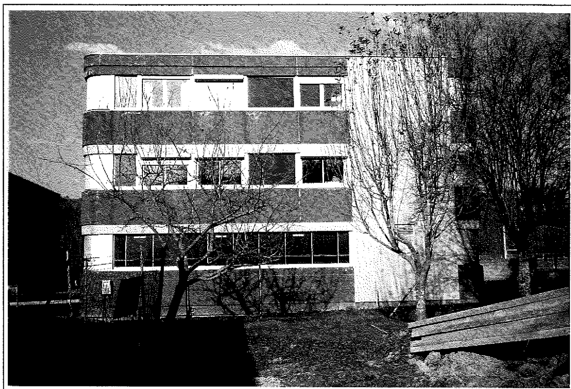
façade Sud des logements
