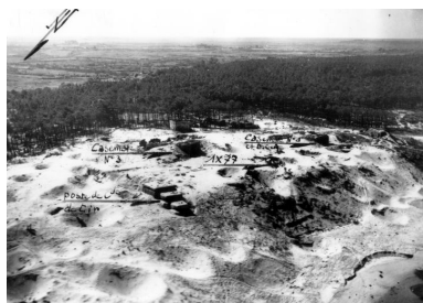
Vue aérienne oblique de la batterie du fort d'Arros. On peut distinguer : le poste de direction de tir, deux casemates et un canon de défense contre avion de 77 mm en encuvement. (Service Historique de l'Armée de l'Air, Vincennes, D 84 190) Phot. Guillaume (reproduction) Lécueillier IVR53_20053300019NUCA
