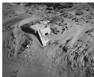
Vue aérienne de l'ensemble fortifié de Soulac : casemate de flanquement (photo n° 62, VII), rapport Pinczon du Sel, vers 1946-1947, Service Historique de la Marine, Vincennes Phot. Guilio (reproduction) Padovani IVR53_20053300015NUCA
