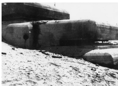
Vue du poste de direction de tir de la batterie du fort d'Arros. (Service Historique de l'Armée de l'Air, Vincennes, D 84 2623) Phot. Guillaume (reproduction) Lécueillier IVR53_20053300020NUCA
