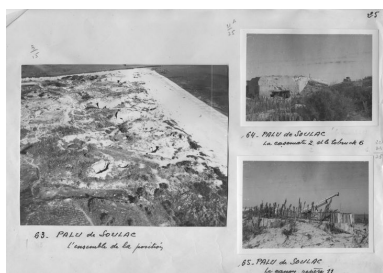
Photographies de l'ensemble fortifié de Soulac (photos n° 63, 64, 65, VII), rapport Pinczon du Sel, vers 1946-1947, Service Historique de la Marine, Vincennes Phot. Giulio (reproduction) Padovani IVR53_20053300016NUCA
