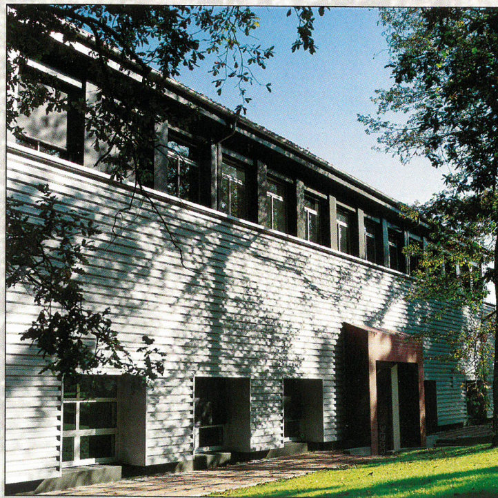
UN BATIMENT REHABILITE
