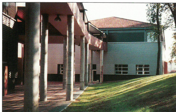
LA GALERIE DE LIAISON ENTRE LES ATELIERS
