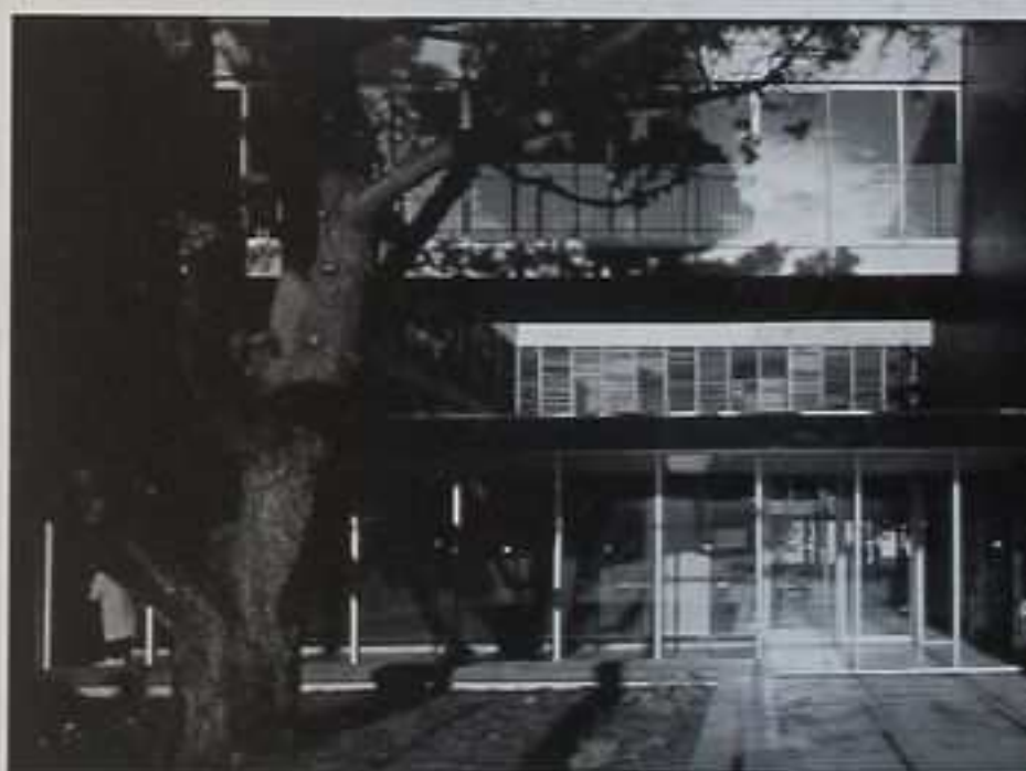
Exterior view Vue extérieure
