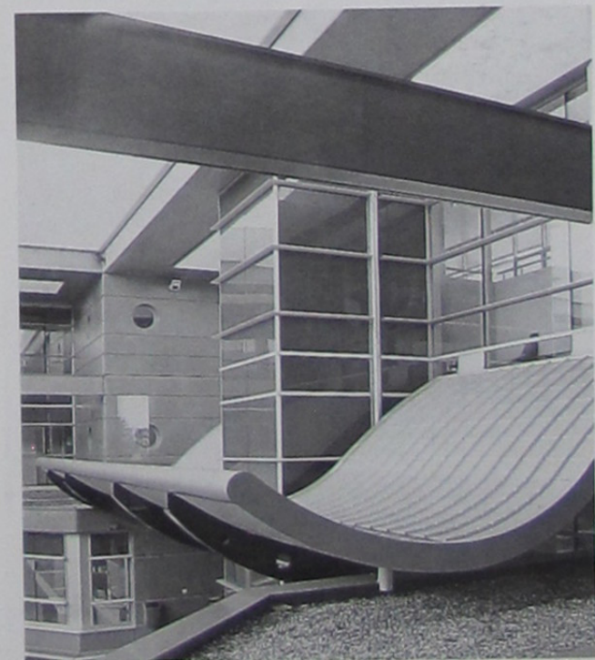
Jeu de courbes et de droites... bac acier pour éléments de toiture et, pour les façades, béton brut et lasuré.
