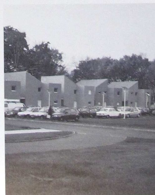
Logements de fonction.
