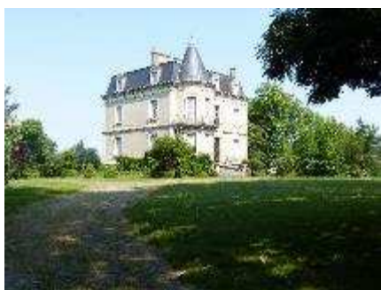
6 rue du Béarn
