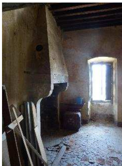
Cheminée des communs, 28 rue du général Lamarque
