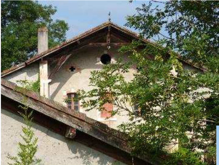
Vue d'un ancien édifice agricole
