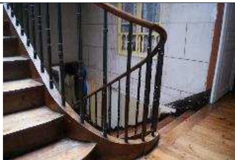
Escalier du 11 rue des Arceaux
