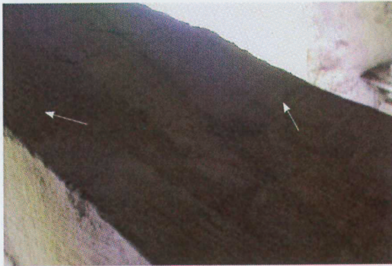
Figure 7 : traces d'outils relevées sur les bois de la charpente. Traces de sciage manuel (probablement sciage de long) sur un arbalétrier (A) et sur un entrait (B). Traces de butée de hache sur un entrait (C).
