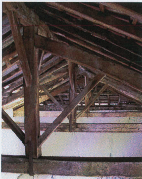
La charpente du trinquet (vue de l'ouest)
