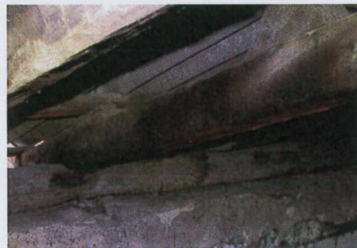
Figure 9 : Prélèvement d'un échantillon à la tarière électrique dans un entrain (ci-dessus).
