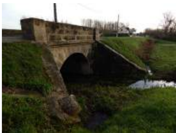
Pont de la D 757 enjambant le ruisseau du Sautard.
