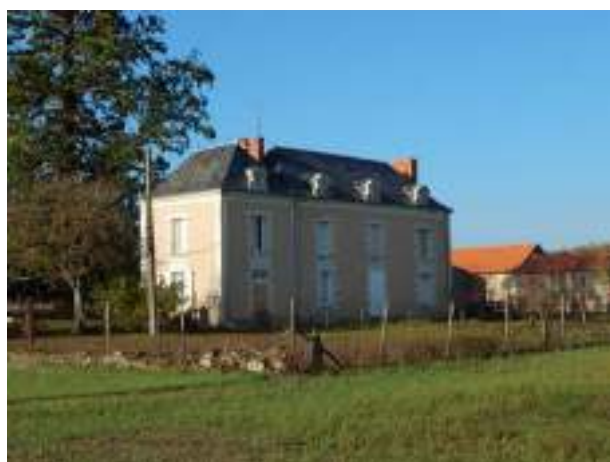
Le château de Gaudion, vue des élévations sud et est.
