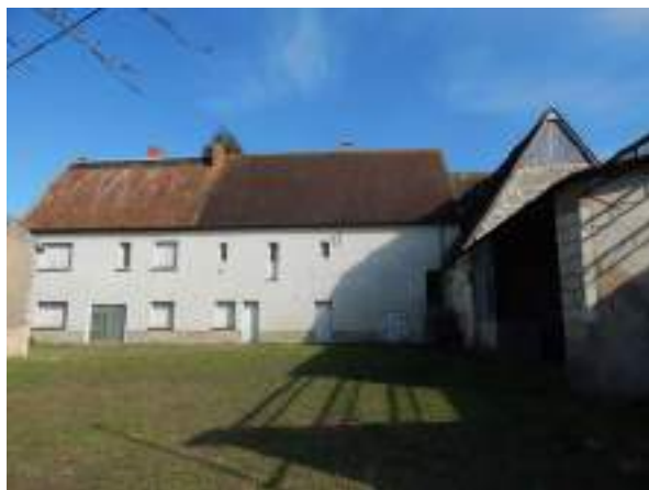
Élévation ouest du logis du couvent des hommes.
