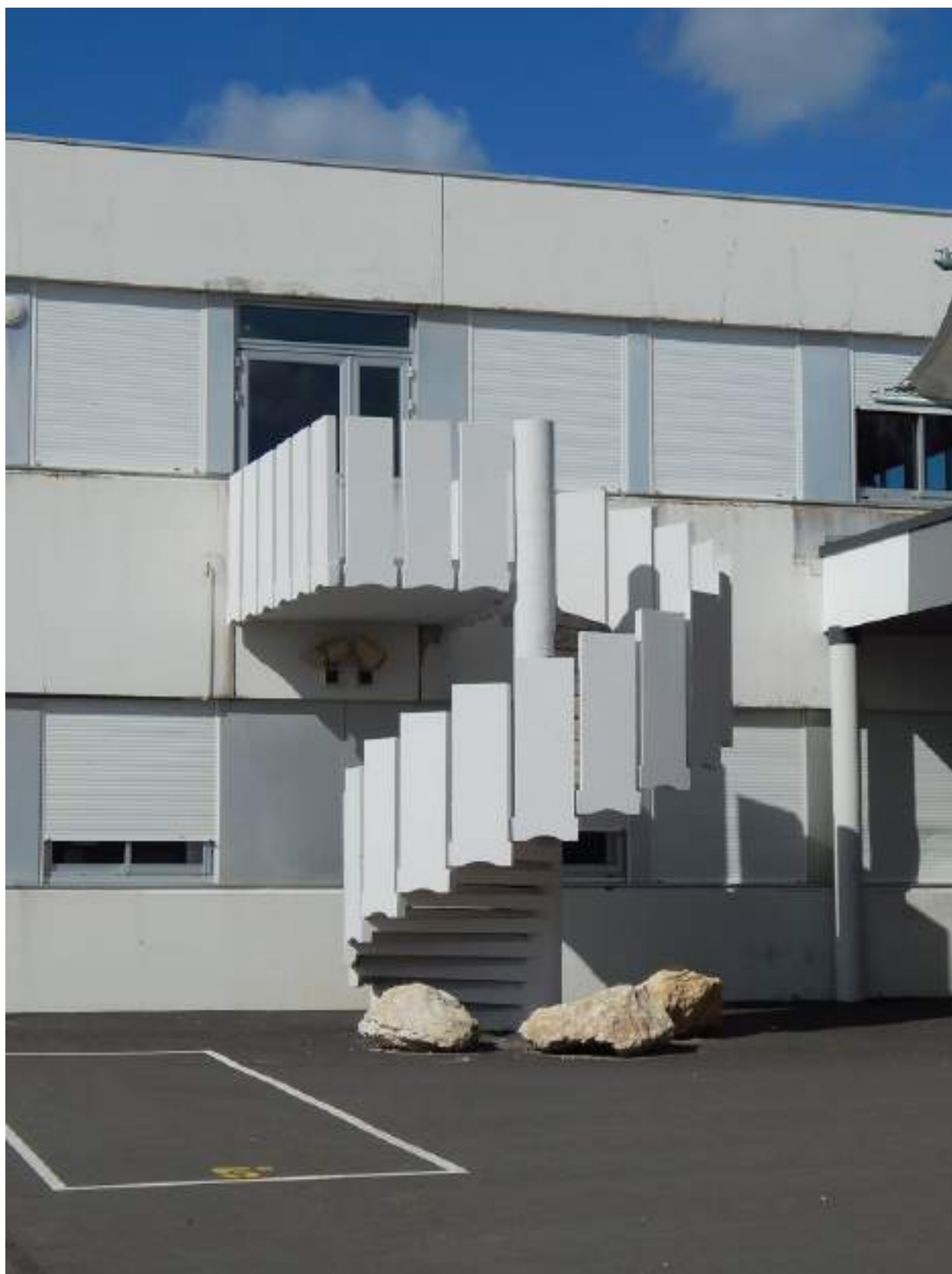
Escalier de secours sur la façade sud-ouest du collège Arsène-Lambert (André Serreau architecte, 1980).
