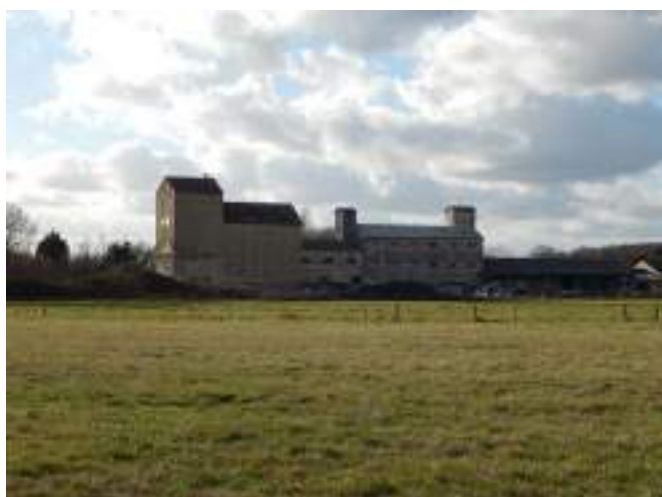
Anciens silos de la Société Coopérative Agricole de Châtellerault (SCAC).
