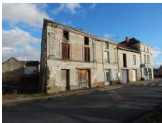
Maisons édifiées vers 1845 rue de la République : les pilastres cannelés qui encadrent le premier niveau sont surmontés d'un chapiteau, une corniche à denticules court sous toute la longueur du toit.
