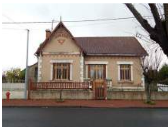
Maison construite au début des années 1930, avenue de la Gare. Elle a conservé ses huisseries d'origine.
