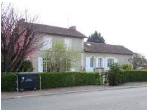
Ancienne gare de tramway.
