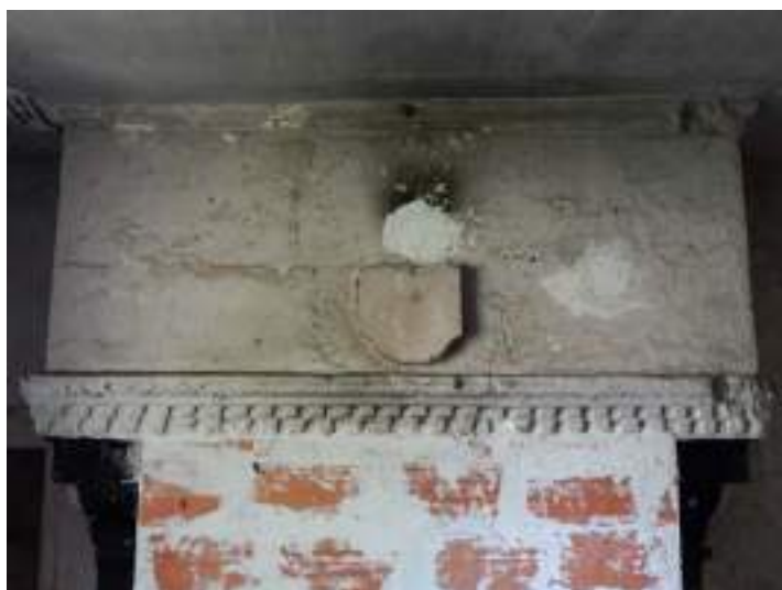
Hotte de la cheminée surmontée d'un blason .
