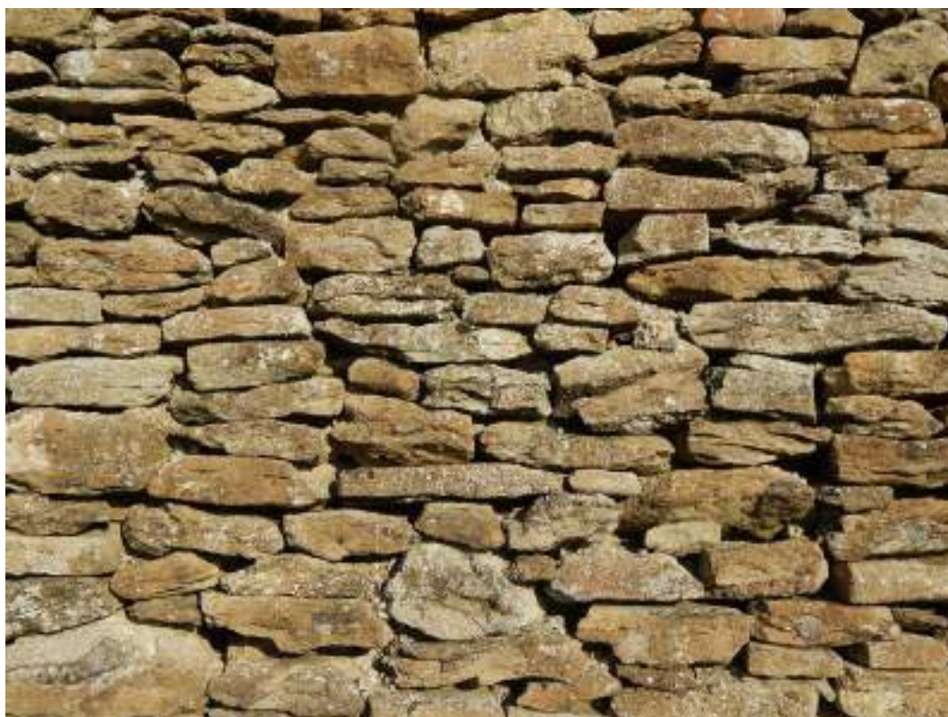
Mur en pierre argilo-calcaire appelée localement pierre de grison.
