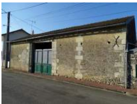
À Bousageau, cette grange a conservé son porche charretier et trois aérations en partie haute.
